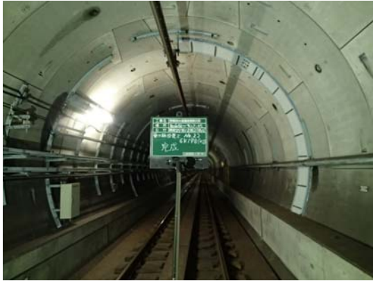
受け樋設置工
