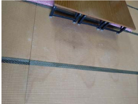
牛久保変電所
