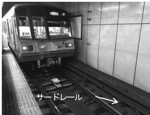
<サードレールの敷設写真>
