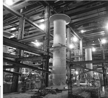
《工事現場の様子》
