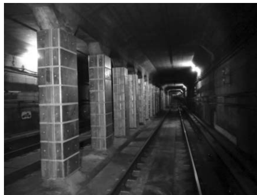
《開削トンネル中柱の補強》
