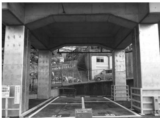
《ラーメン高架橋の橋脚の補強》
