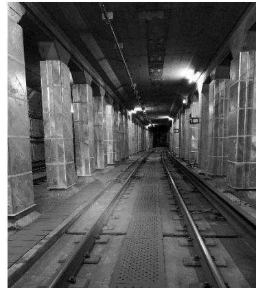
<開削トンネル部>
