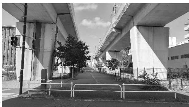
<センター南北駅間高架下>
