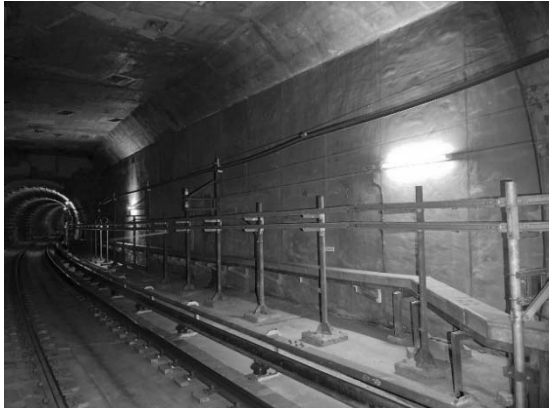
<開削トンネルの補修>
