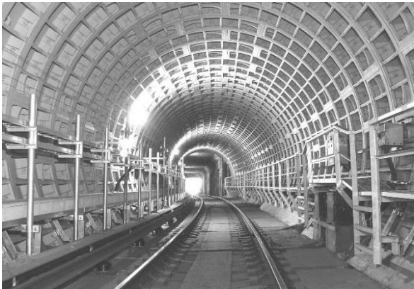
<シールドトンネルの補修>
