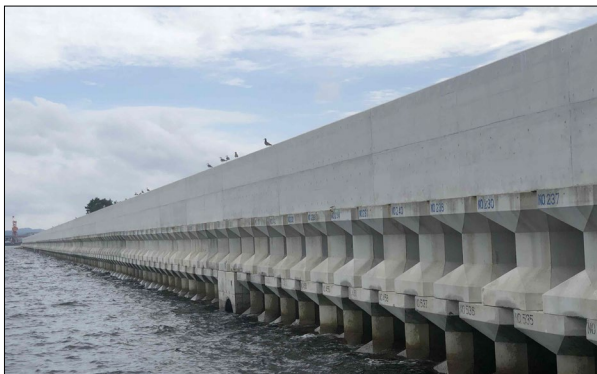
【金沢区福浦地区護岸復旧状況】
