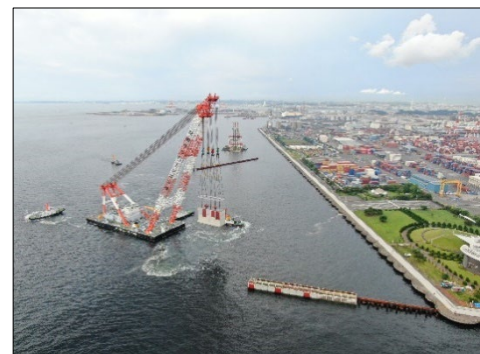
【ケーソン据付状況】
