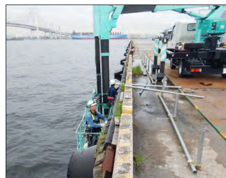
【岸壁補修工事】
