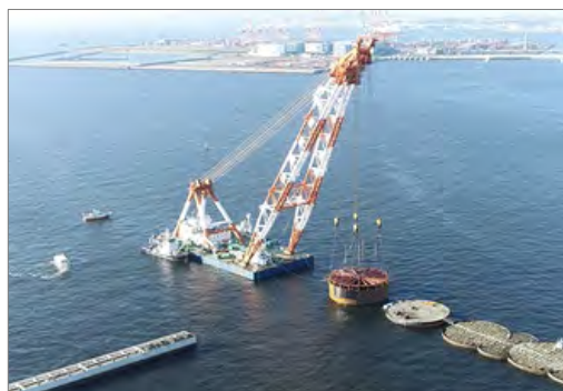
【鋼板セルの設置状況】
