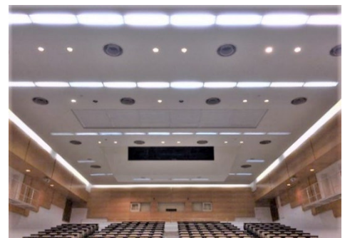
シーガルホール天井
