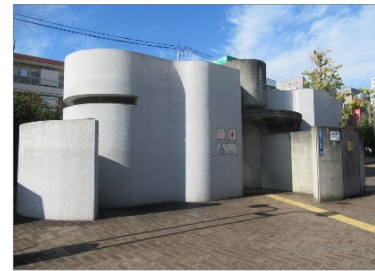
青葉台駅前公衆トイレ
