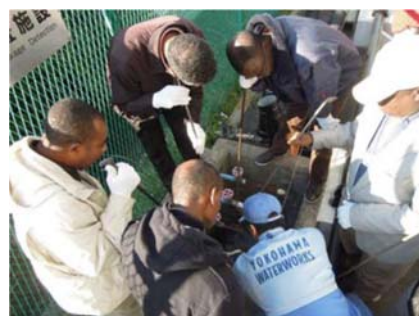
漏水調査実技研修
