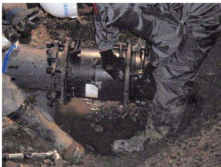
配水管の布設替工事
