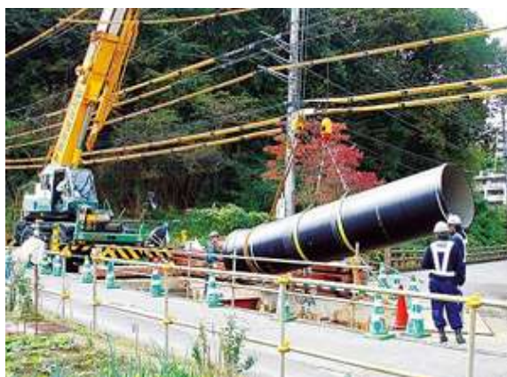
地震に強い水道管への取替工事
