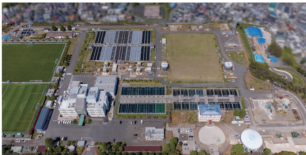
西谷浄水場(再整備事業前)
