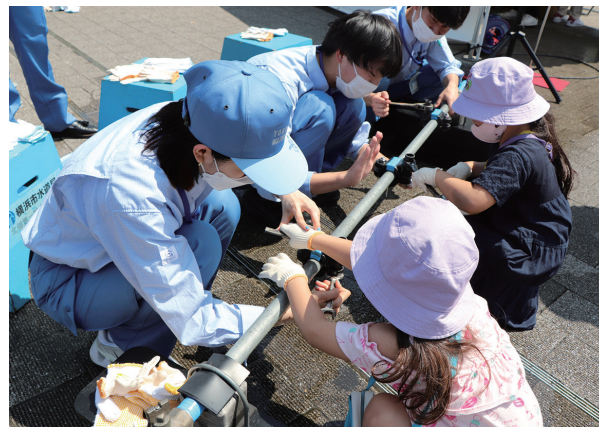
イベントでの漏水修理体験
