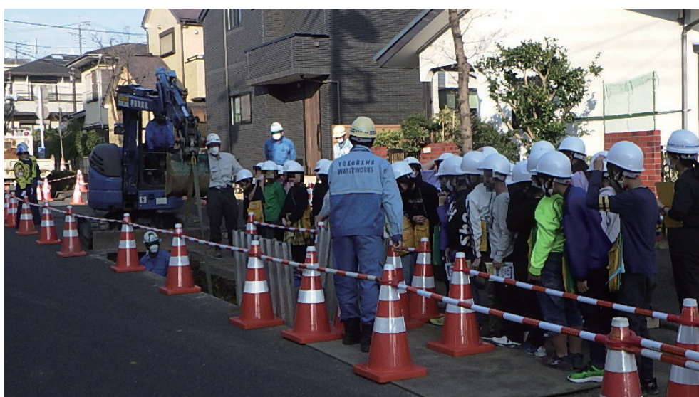
工事現場見学会の様子
