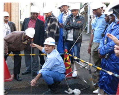
アフリカからの研修生受入れ (漏水修繕工事の様子)
