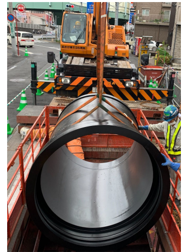
口径1350mm配水管更新工事
