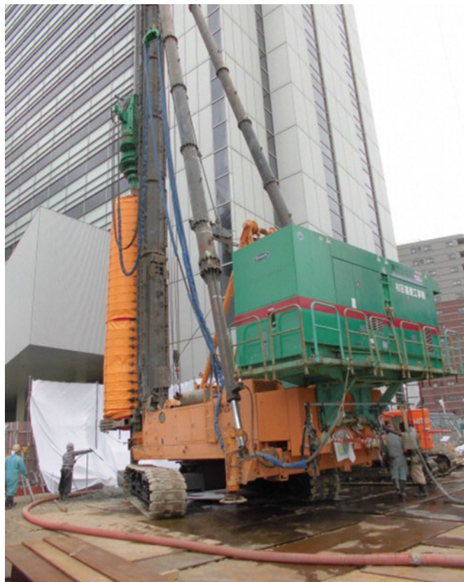
既成杭工事 (みなとみらい線馬車道駅接続)
