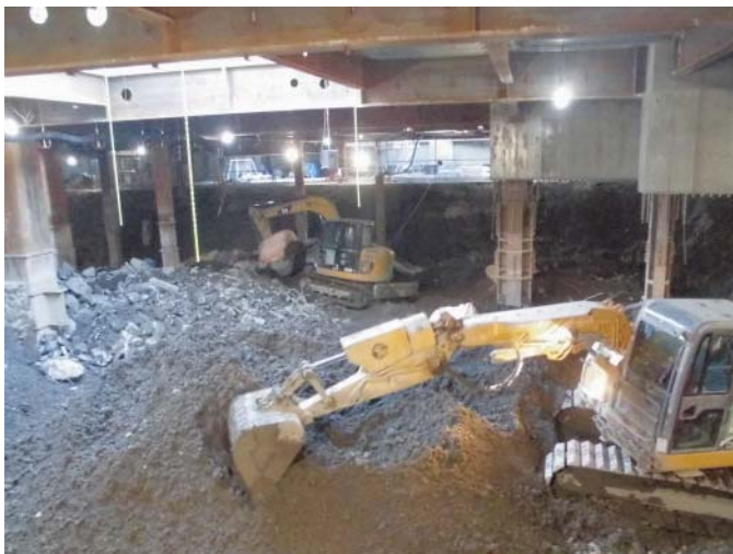
ショートルーチバックホウによる掘削した土の集積状況
