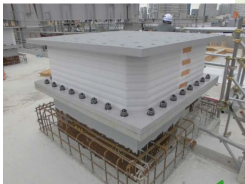
免震装置 設置工事
