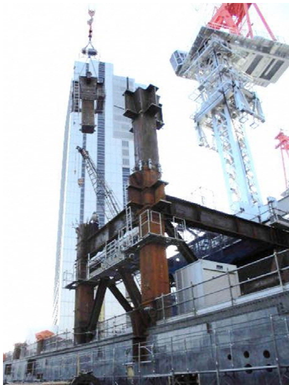
タワークレーンによる 地上鉄骨建方
