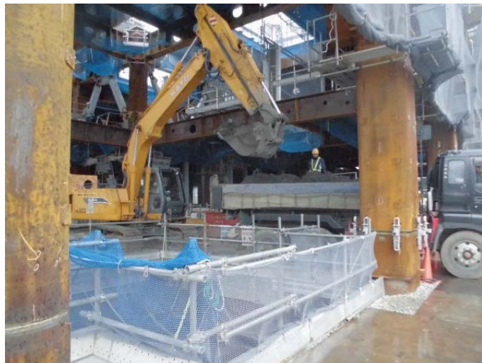
テレスコ（伸縮）式バックホウによる掘削した土のダンプへの積込み
