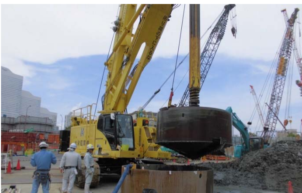
着工後の現場の様子 (杭の掘削工事)
