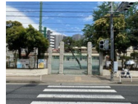
⑤横断歩道先の正門を見る
