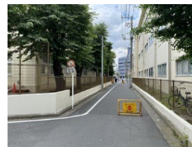
⑪東側道路と東校舎を見る
