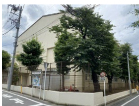
⑨南側道路より体育館棟を見る
