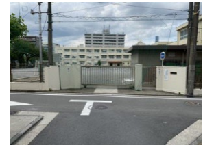
⑧グラウンド南側出入口を見る
