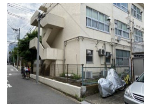
⑫南側道路より東校舎を見る
