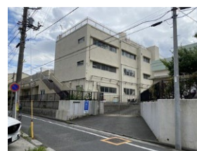
⑮東側道路より給食棟入口を見る
