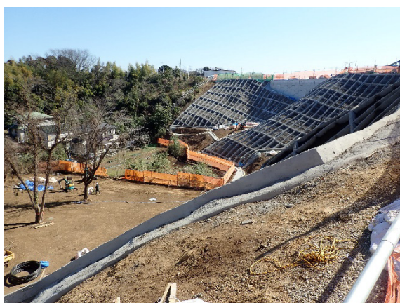
施工後(令和5年3月)
