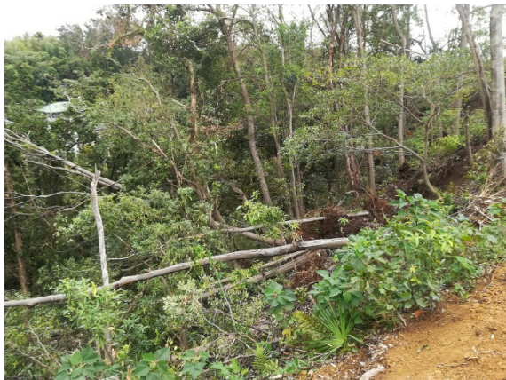
施工前(倒木状況)
