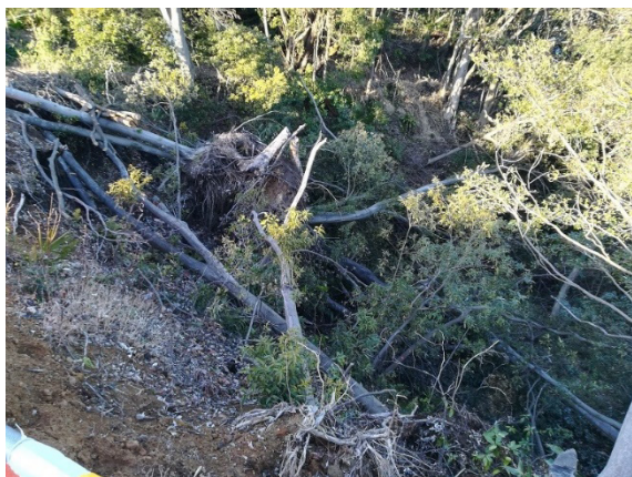
施工前(土砂崩れ)
