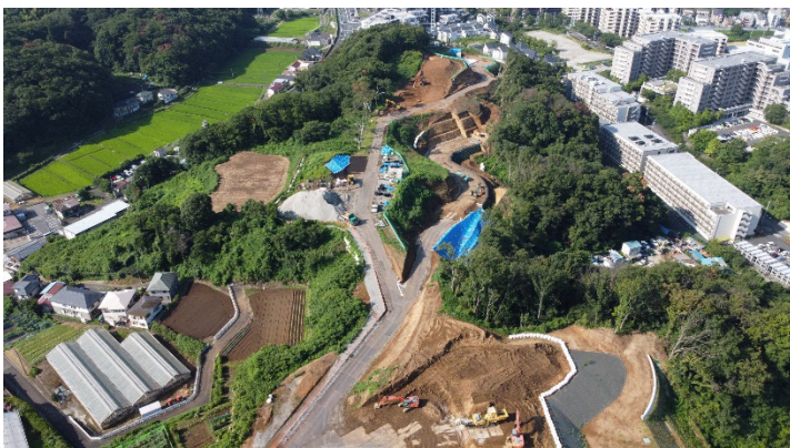
工事写真①
