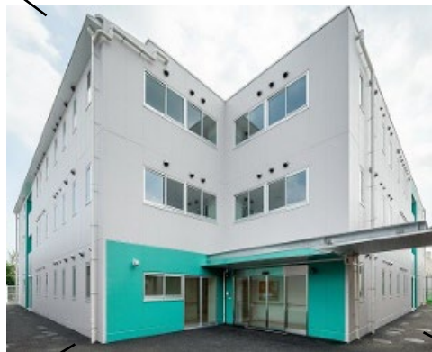
新居住棟 (東棟) (R4.9しゅん工)
