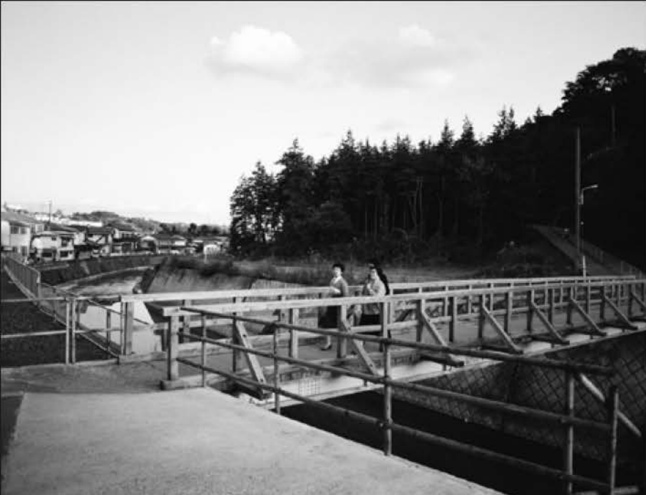
帷子川に架かる木橋の学校橋
