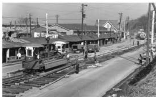
市町延伸工事 保土ヶ谷駅前
