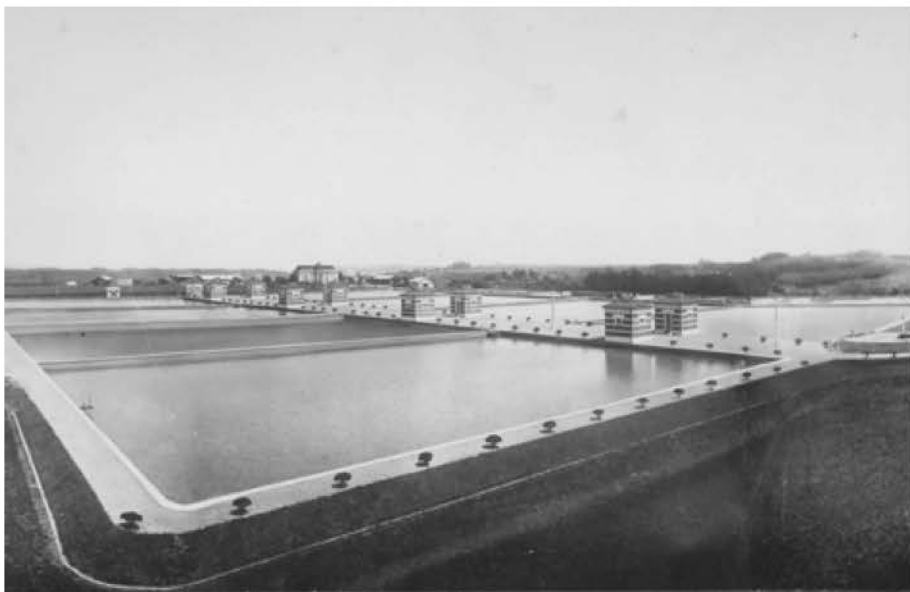
昭和7年 西谷浄水場
