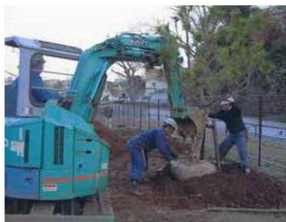
松籠付け作業(瀬戸ヶ谷中公園)
