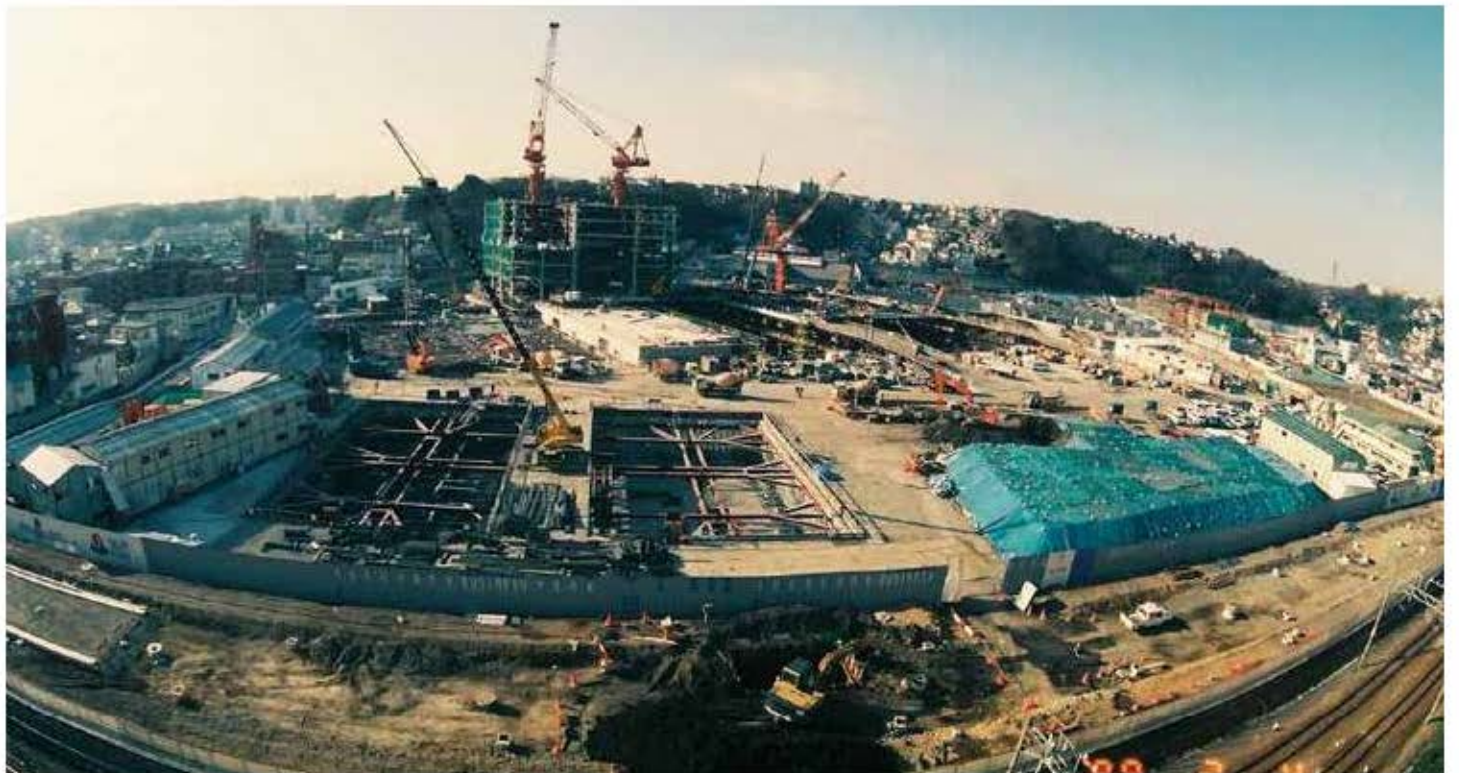
建設中の横浜ビジネスパーク
