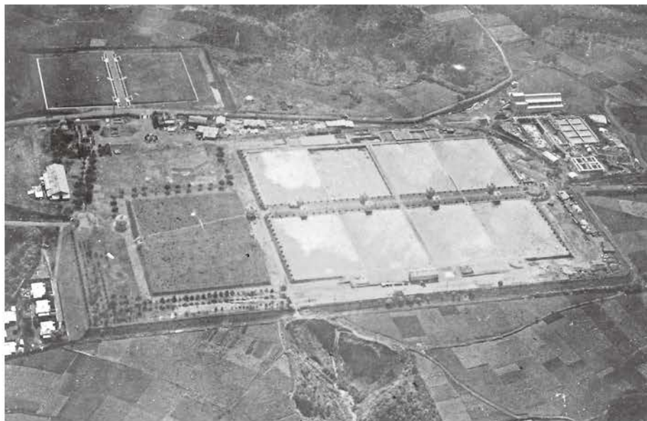
昭和7年の西谷浄水場(空撮)
