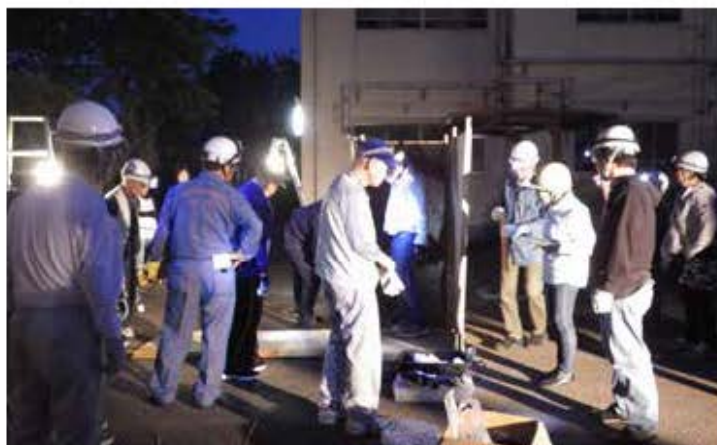
夜間訓練(トイレ組立)
