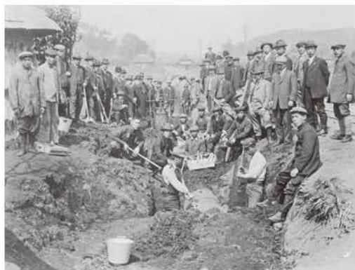
大正3年頃 仏向和田町間36インチ管敷設工事
