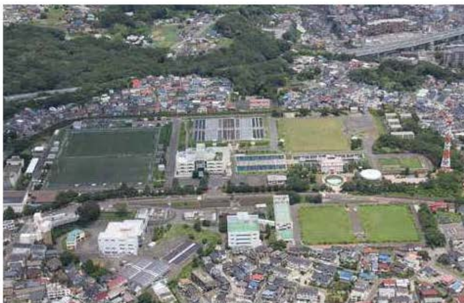
現在の西谷浄水場(空撮) 平成29年(2017)撮影
