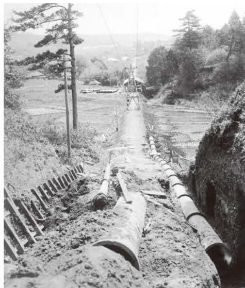
現東門から見た西谷浄水場からの配水管敷設工事
