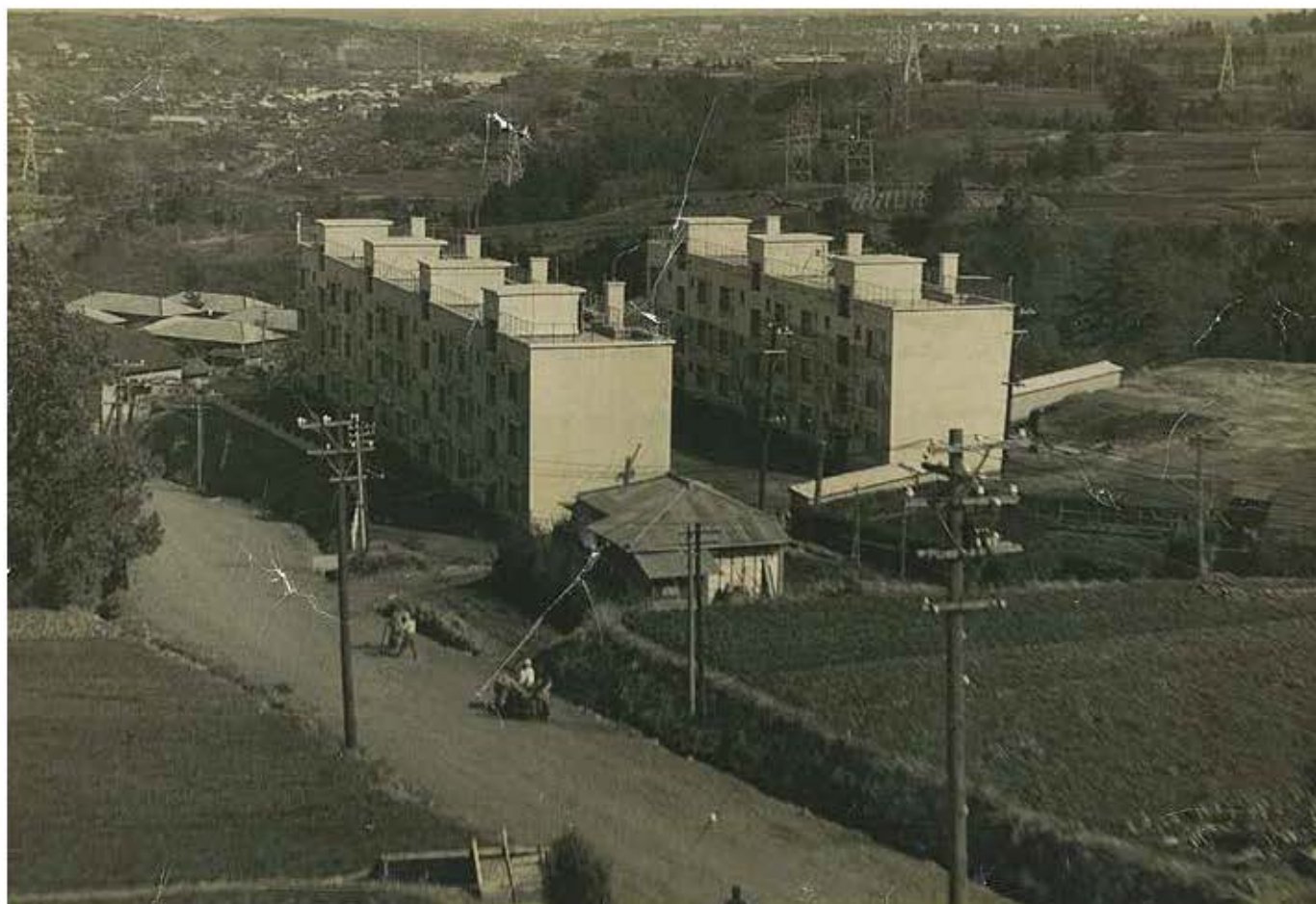
西谷浄水場から横浜港方面を望む(昭和27年11月頃、撮影：内田久雄)
