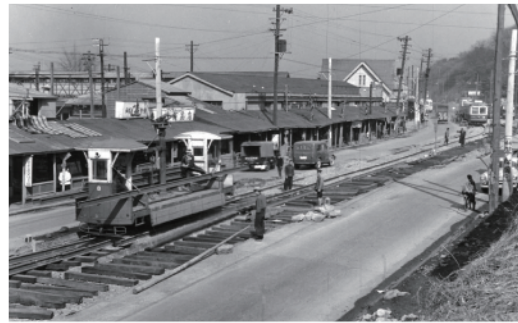
市電延伸工事 保土ヶ谷駅前
