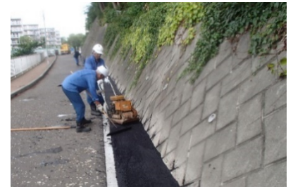
<道路の補修作業>
