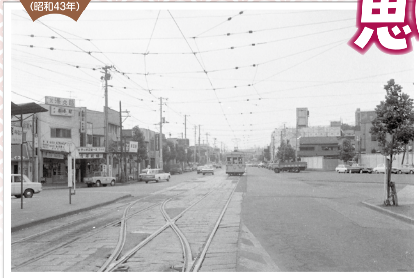
1968年 (昭和43年) 東神奈川駅西口付近 写真:神奈川図書館
