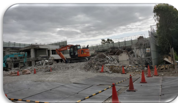
【B棟解体 日中活動棟建設中】
