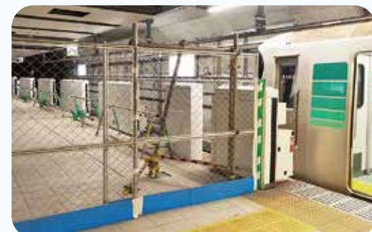
工事中の日吉駅ホーム
