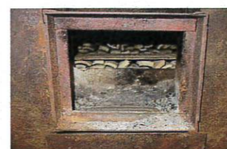
焚口据え付け後の様子
