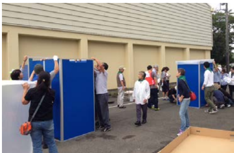
下水直結式仮設トイレの組み立て
