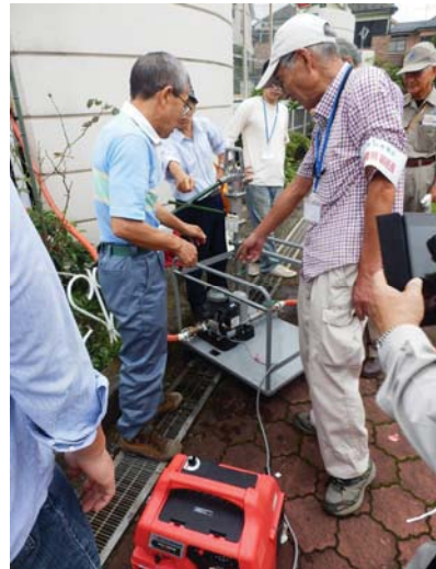
ポンプの作動確認
