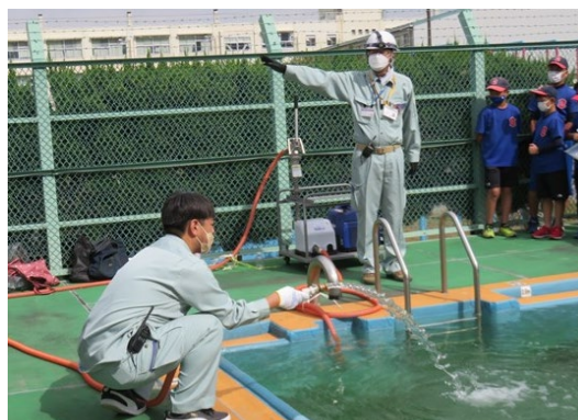
受水槽から応急給水
