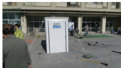
下水道直結式トイレ設置
