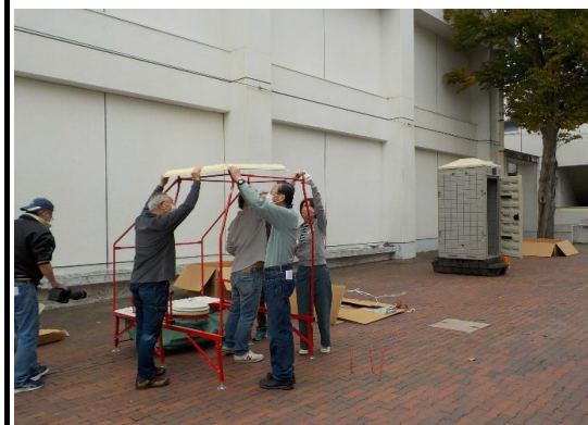
組立式仮設トイレ設営
