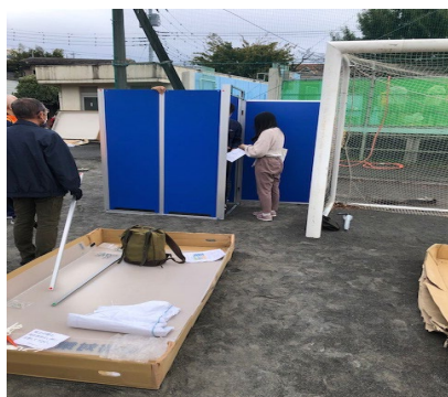
下水道直結式トイレの組立
