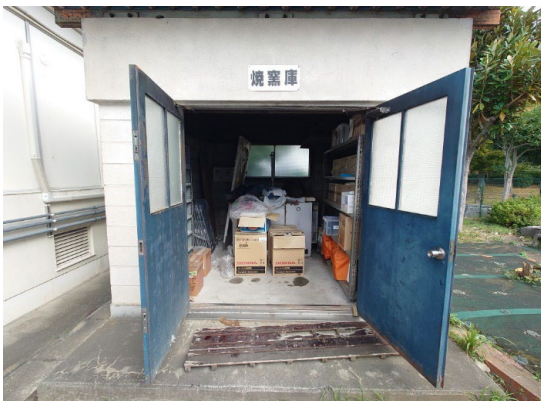
備蓄庫(ガス式発電機、エンジンカッター等)
