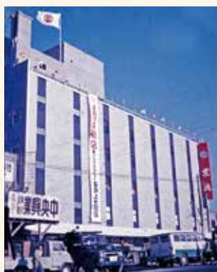
昭和38年に完成した駅ビル。1階に改札口、上階には上大岡初の大型商業施設として京急百貨店が開業(渡辺さん提供)
