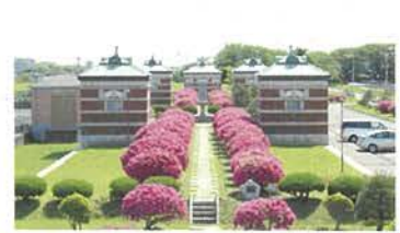
西谷浄水場濾過池整水室上屋3号棟
