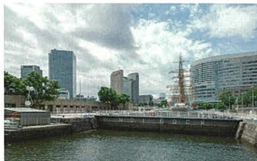
[図1-36] 旧横浜船渠株式会社第一号船渠
