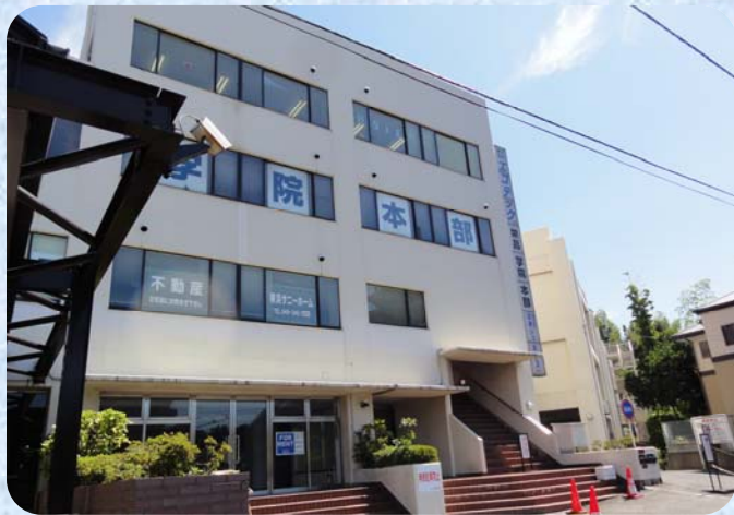
相鉄線上星川駅から歩いて4分ほどの国道16号線沿いにあります。
