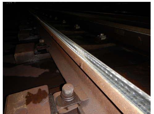
高速グラインダーで削正後のレール
