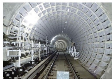
シールドトンネル補修
