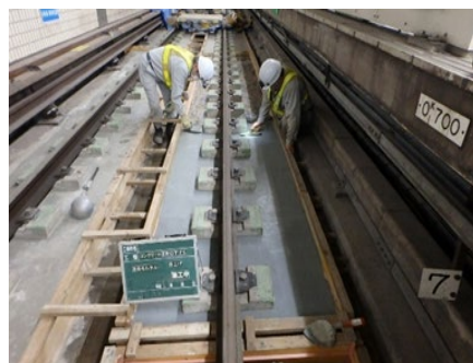
軌道改良工事
