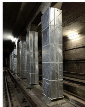
トンネル部の耐震補強工事
