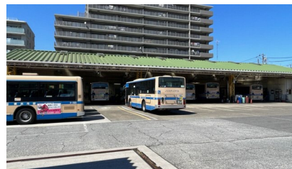
緑営業所車両整備工場
