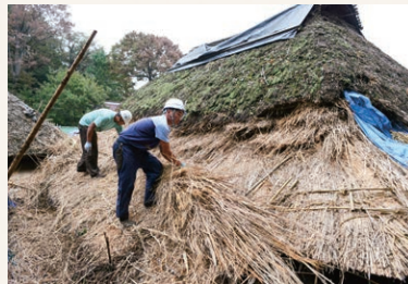
平成30年(2018)の茅葺屋根葺き替え作業の様子
