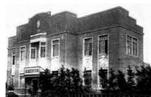
第二仮本館(「横浜市図書館概要」)
