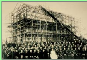
長津田乾藪倉庫-建設途中 (撮影：1929年)
