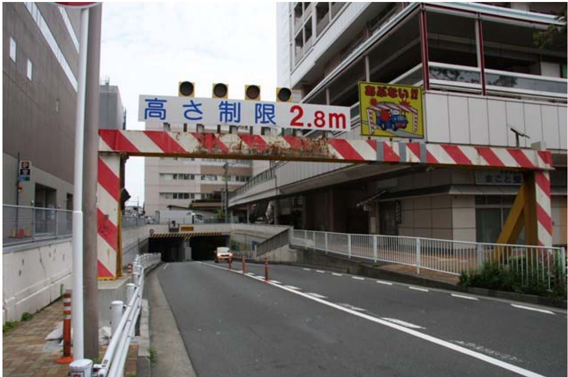
京急線側から
