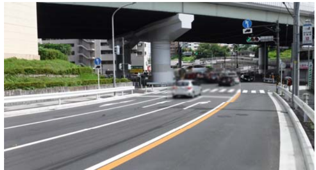
状況写真(実施後)
