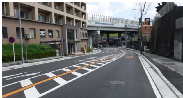
状況写真(実施後)
