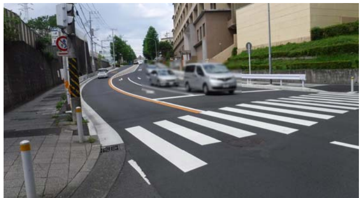
状況写真(実施後)
