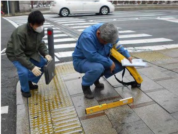
歩道の勾配の確認
