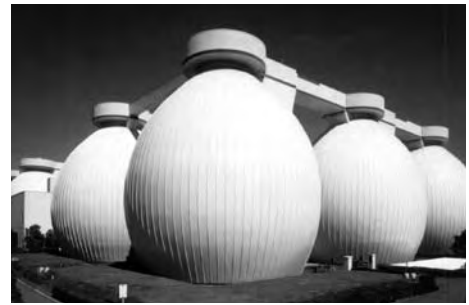
図1-7 北部汚泥資源化センター消化タンク
