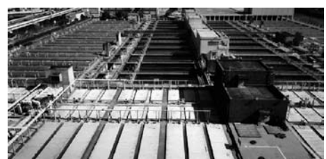
図 4-8 神奈川水再生センター（神奈川区）
