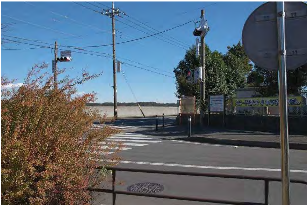
写真 9.13-17(3) No. 6 上瀬谷町東公園（構造物の存在）
