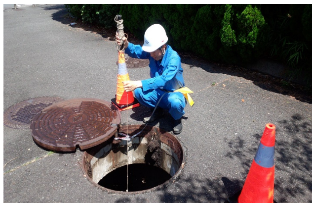
異常流入発生時の汚水管調査
