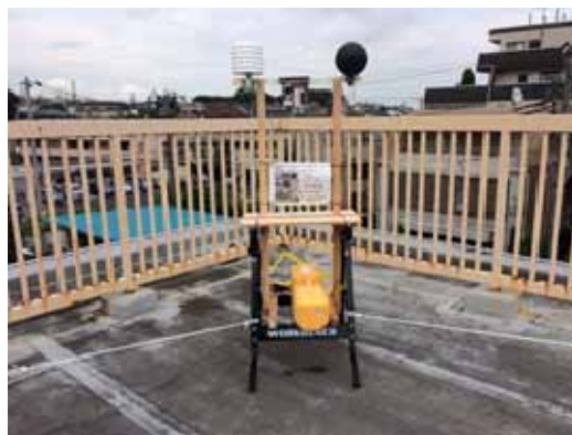
写真 3 現場の設置風景
