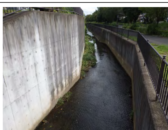
鳥山川上流(下流側)St.1 鶴見川水系(2015年9月14日)天屋二の橋
