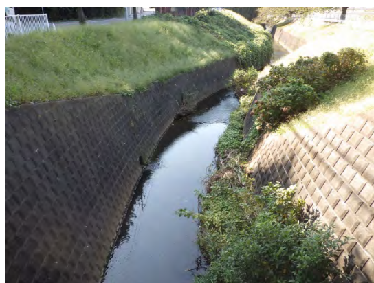
奈良川上流(下流側)St.8
