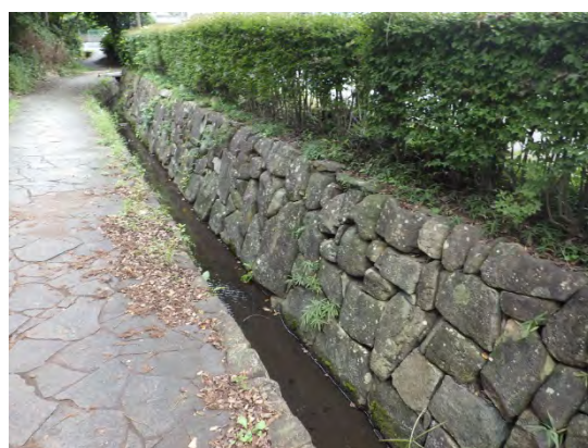
帷子川源流(下流側)St.15 帷子川水系(2015年9月14日) 上川井町小川アメニティ
