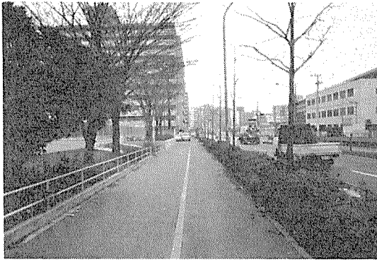
写真 I - 15 F地点 (A, B地点植樹帯設置1年後) 調査番号 VI
