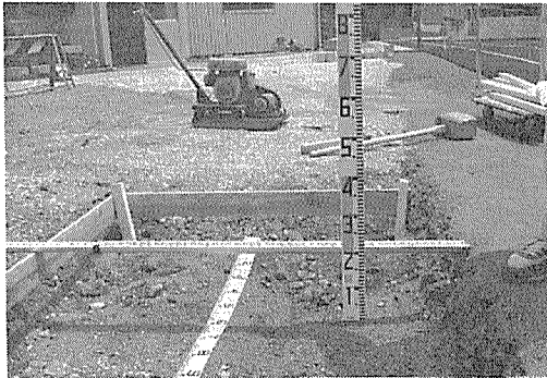
写真-5 施工路床
