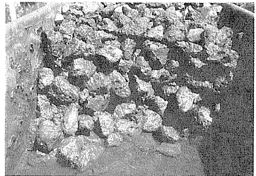
写真-3 水抜きした礫充填水路
